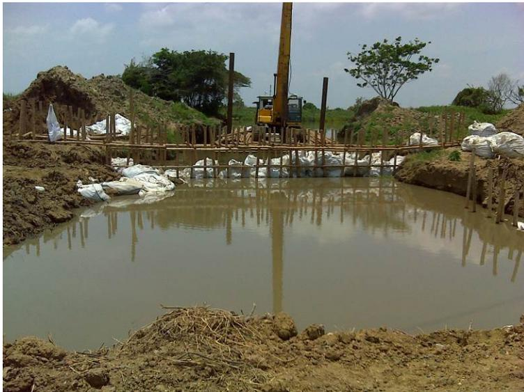
**OBSERVACIONES:** se visualiza en la imagen cierre del boquete abierto de manera controlada en dique viejo - plan de evacuación de aguas del sur del Atlántico, de igual manera el material utilizado como estructuras para el cierre de los boquetes abiertos de manera controlada en Dique Polonia.
