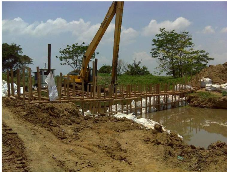
**OBSERVACIONES:** se visualiza en la imagen cierre del boquete abierto de manera controlada en dique viejo – Maquinaria utilizada para realizar dicha actividad.
